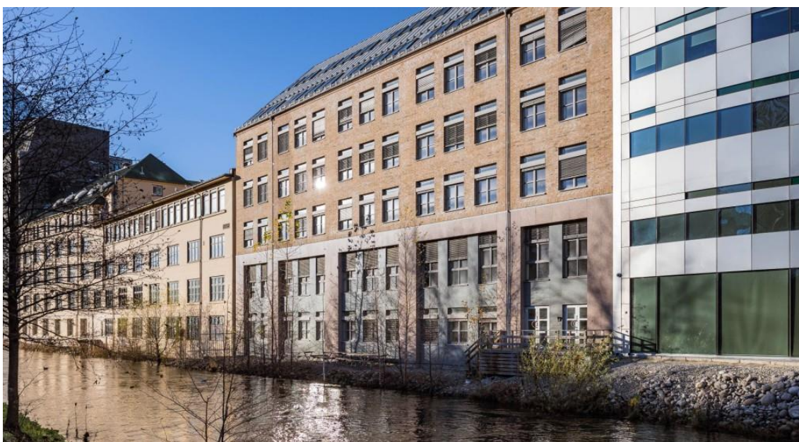
Frivillighetens Hus ligger sentralt til ved Akerselva. Våre kontorer ligger i 3. etg, mot elven.
